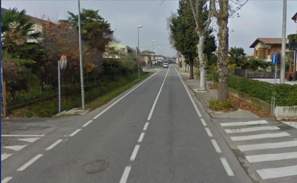
La Via Erizzo che conduce al centro di Pederiva propone un unico marciapiede sul lato nord che si presenta in condizioni critiche: la pavimentazione sconnessa, ostacoli da segnalare, raccordi tra i vari livelli da sistemare, ecc.... Attualmente il percorso risulta in parte inaccessibile per le persone con limitate capacità motorie.
